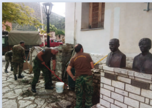
Εργασίες συντήρησης Πλατείας στο Χωριό Πλαίσιο Θεσπρωτίας από Εθνοφύλακες του ΤΕΘ ΗΓΟΥΜΕΝΙΤΣΑΣ
